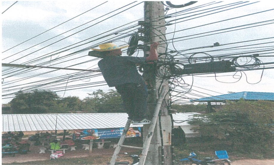
ภาพถ่ายซ่อมไฟสาธารณะ หมู่ที่ ๖ บ้านทุ่งหนองแขวน
