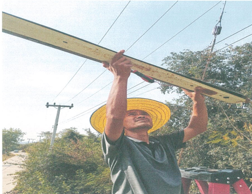
ภาพถ่ายซ่อมไฟสาธารณะ หมู่ที่ ๓ บ้านมะเกลือ
